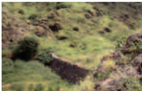
Fig. 9 Dighetta per trattenere l'acqua ed infiltrarla nel terreno (Ribeira da Prata, isola di Santiago, Capo Verde)
